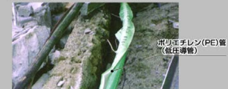
▲地震に震出しても破損のなかったポリエチレン管(低圧導管)(神戸市長田区)
